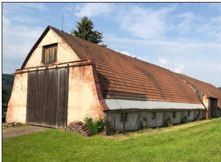
objekt skladové haly v Řetůvce
