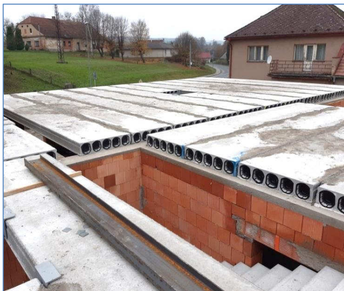
podzim 2020 - hrubá stavba přízemí
