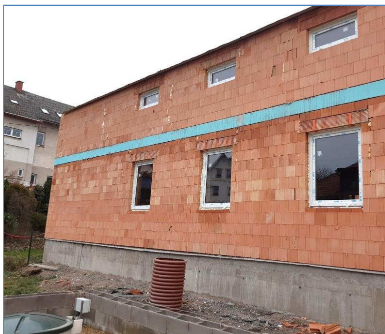
před zimou objekt dostal okna
