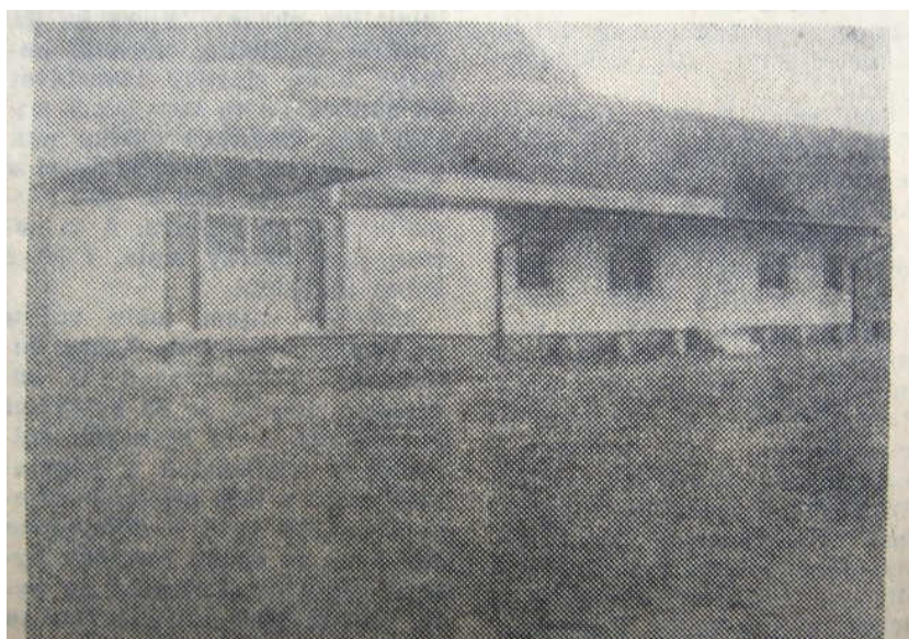
Nově vybudované kabiny na fotbalovém hřišti Sokola Řetová. Hodnota objektu je 73 tis. korun a bylo na něm odpracováno přes 2000 hodin. Foto: M. Renčín
